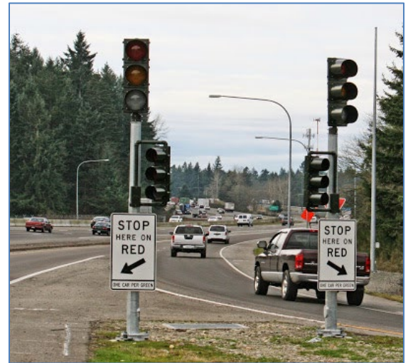
WSDOT Ramp Meter
